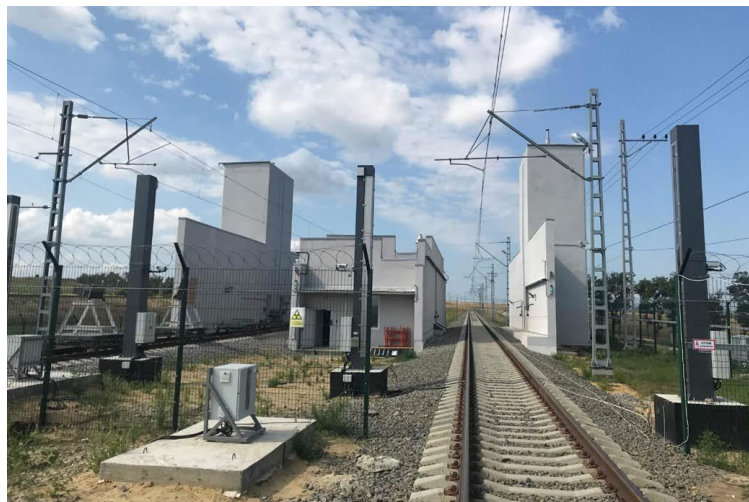
Двухпутевой ж-д ИДК
